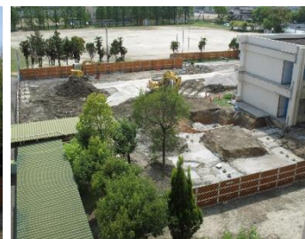
杭を打ち終わった箇所
